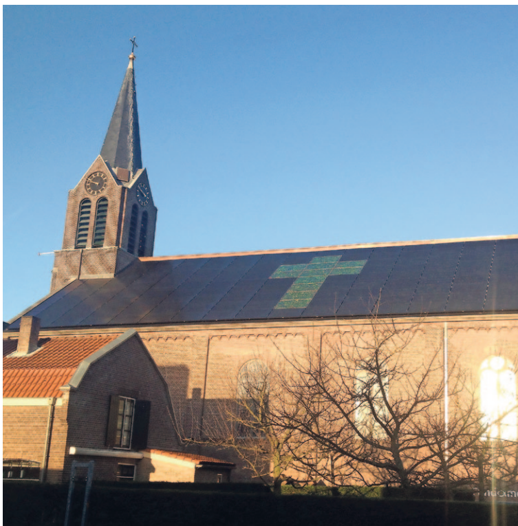
Het ‘zonnedak’ maakt de Joannes de Doperkerk in Hoofddorp elektrisch zelfvoorzienend. Foto: Kapitein Installateurs
